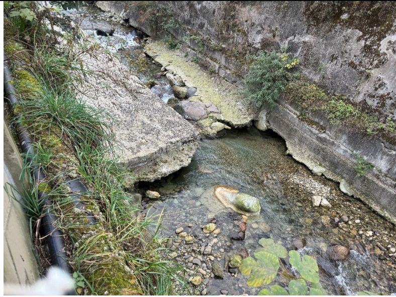
图 3-4 底板修复部分现状图
