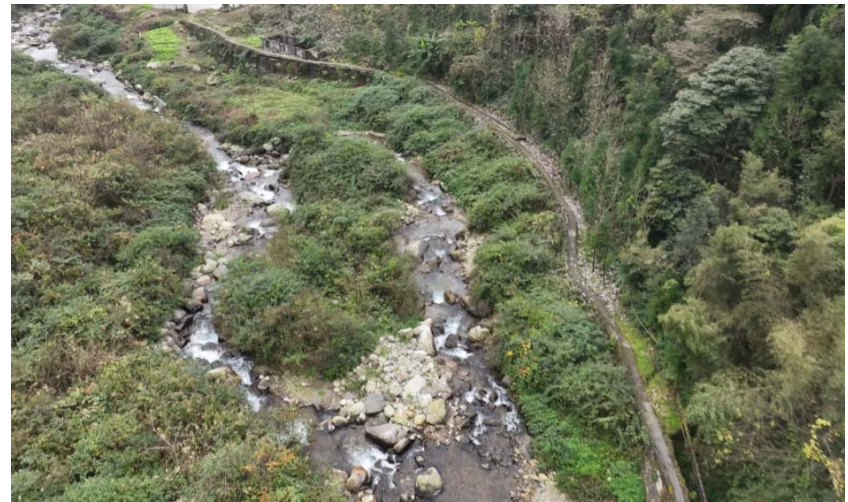
图 3-3 护脚修复现状
