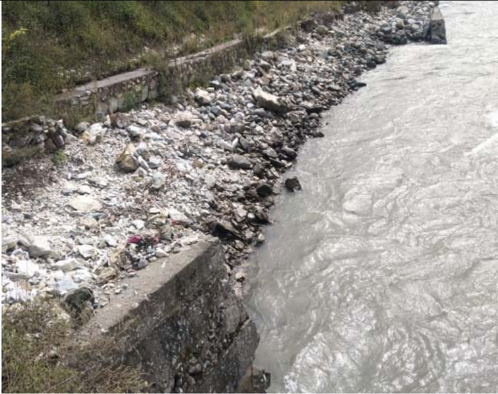
岷江七盘沟村段堤防现状图
