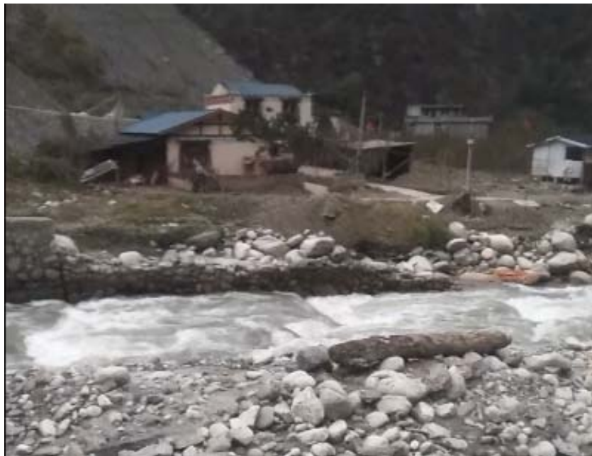
草坡河足湾村刘家河现状图
