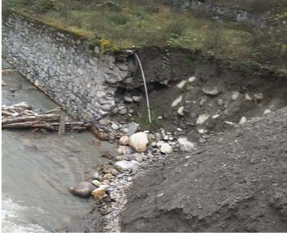
草坡河克充村公路桥下游现状图
