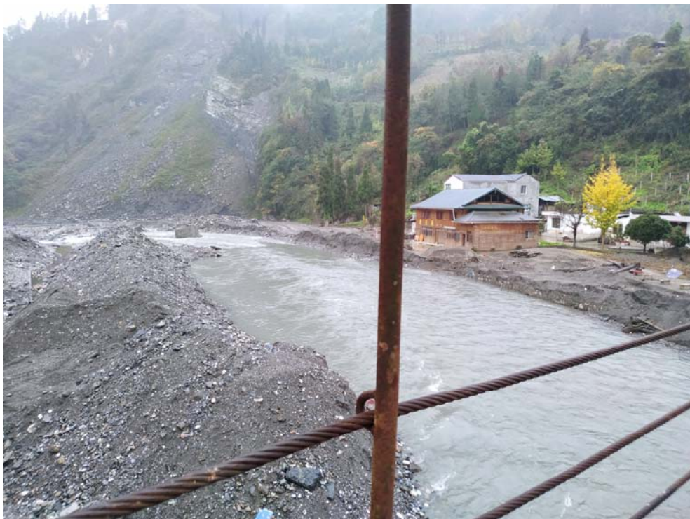
街村段右岸堤防终点位置 1
