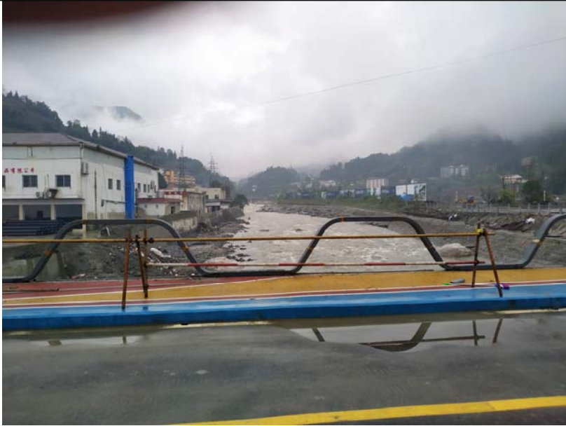
河坝村段终点附近阻洪桥上游现状
