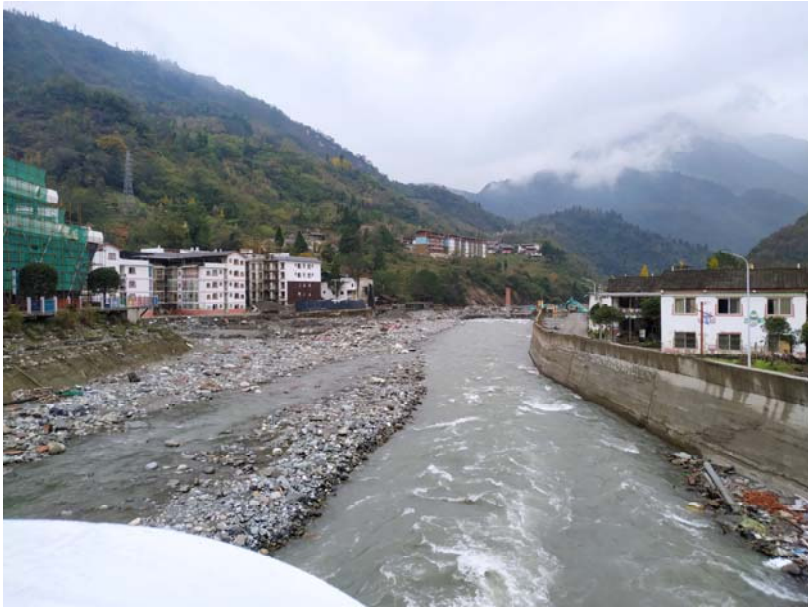
河坝村终点附近阻洪桥下游现状
