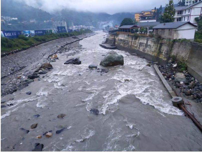
河坝村段左右岸堤防现状
