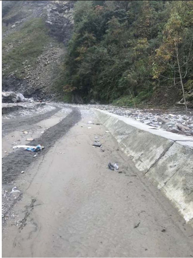
街村段右岸堤防终点位置 2
