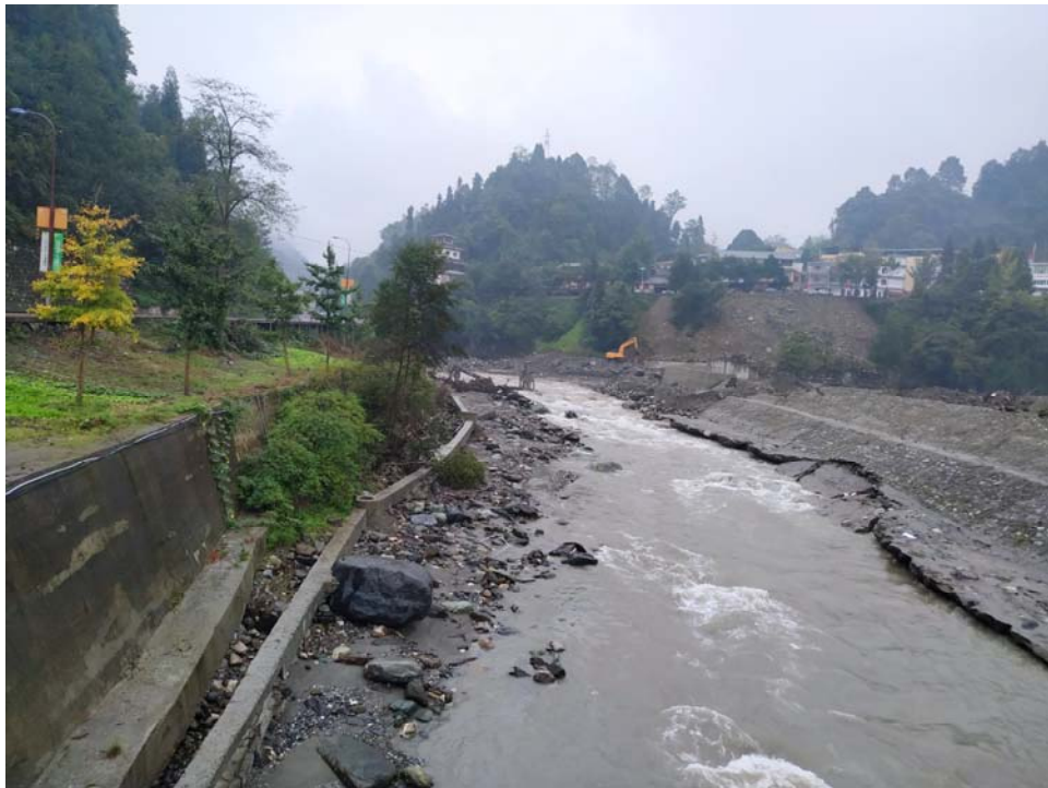
河坝村段左右岸起点堤防现状
