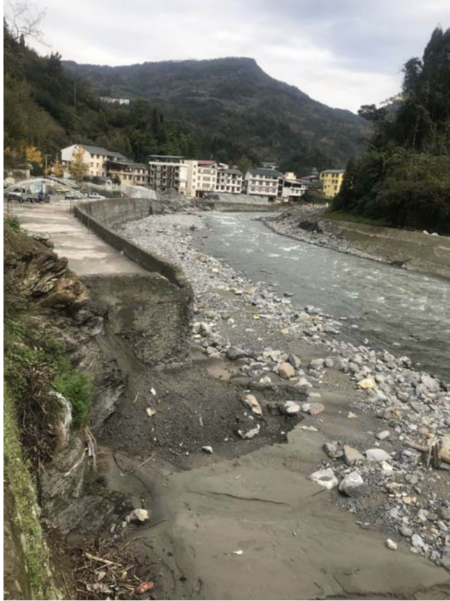
街村段左岸堤防起点位置
