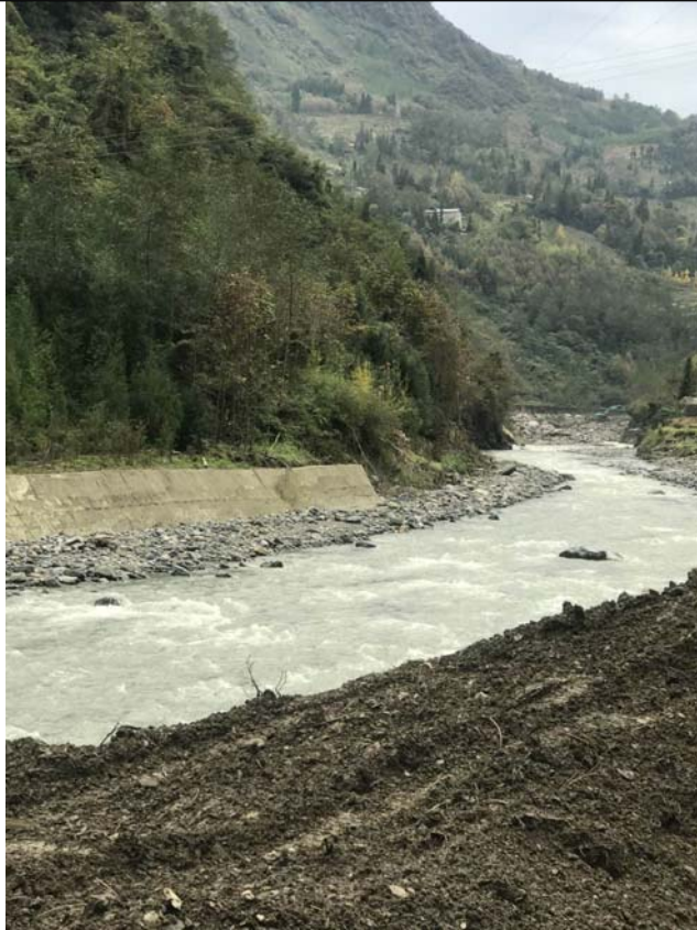
街村段右岸堤防起点位置
