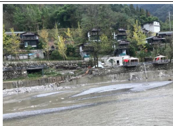
图 1-2 污水管线直排入河道
