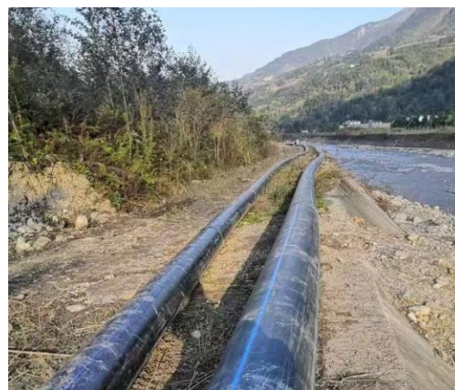
图 1-2 白石水厂现状（二）
