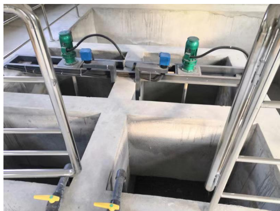
图 1-1 白石水厂现状（二）
