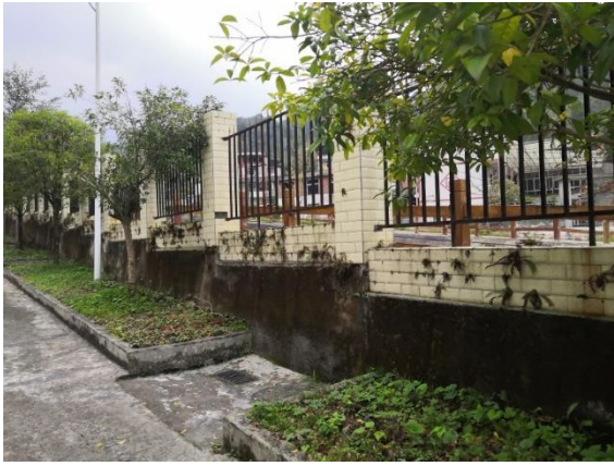
图 1-3 大岩洞水厂现状（二）
