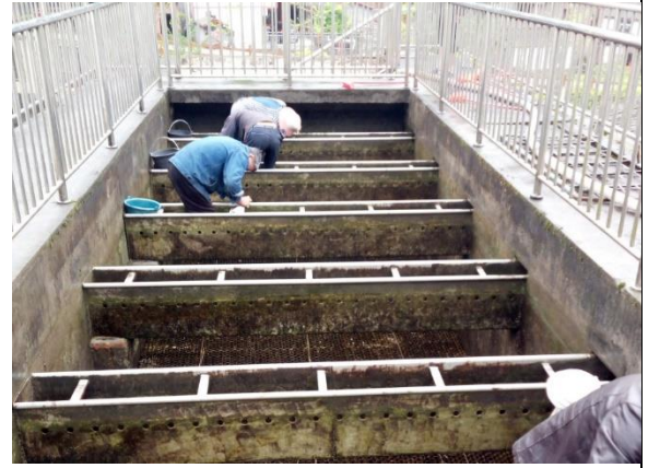
图 1-4 大岩洞水厂现状（二）
